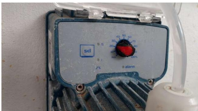
**Figura 3.** Botão vermelho, potenciômetro da bomba dosadora
