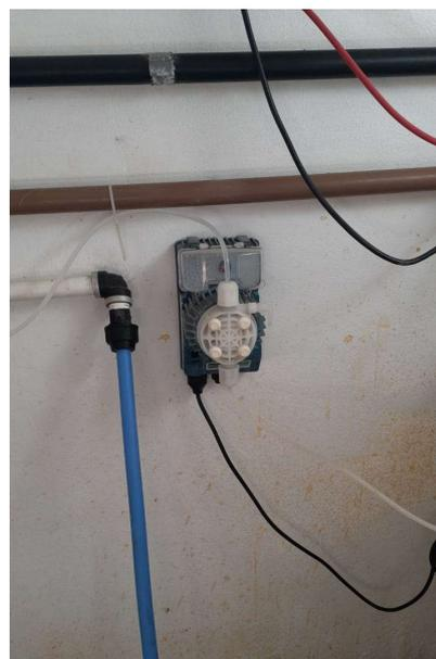
**Figura 2.** Bomba dosadora de cloro
